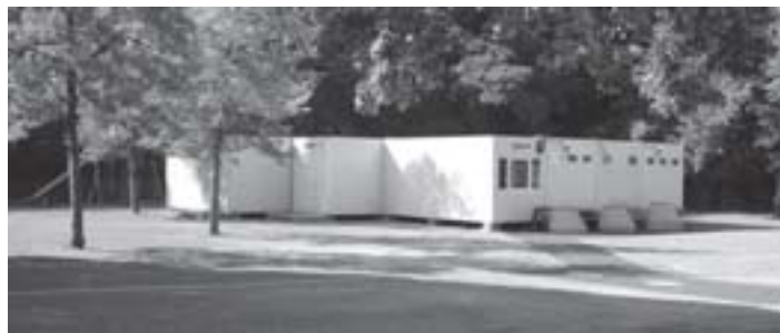
Die neuen Klassencontainer im Pausenhof der Grandlschule.
