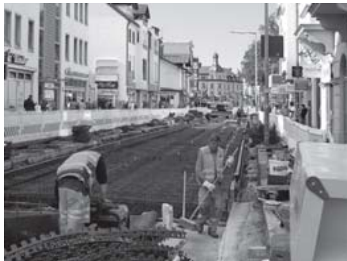
Einbau der Gleise in die Gleichmannstraße für die neue Trambahnführung der Linie 19 zum Pasinger Bahnhof, August 2012.
