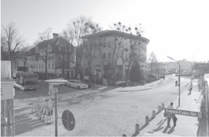
Der gesamte Bereich vor dem Nordausgang des Pasinger Bahnhofs soll umstrukturiert und neu gestaltet werden.
