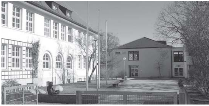
Die Schulen an der Grandlstraße: von außen durchaus ansehnlich, jedoch dringend sanierungs- und erweiterungsbedürftig.
