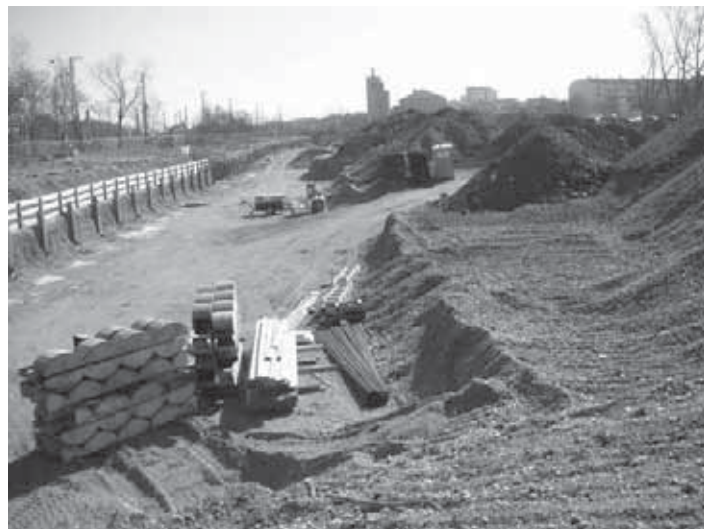
Südlich der Bahngleise wird bereits fleißig gebaggert. Die Aufnahme zeigt die Baugrube aus Richtung des Pasinger Bahnhofs.
