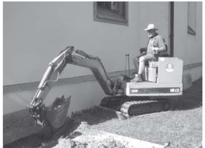
Josef Kinast hebt mit seinem Kleinbagger Schürfruben nach den Vorgaben der Fachleute aus.
