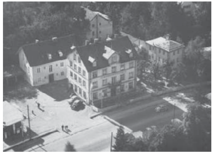
Das ehemalige Restaurant „Einkehr Hofgarten“ an der Menzinger Straße soll abgerissen werden. Postkarte aus den 1960er Jahren.
